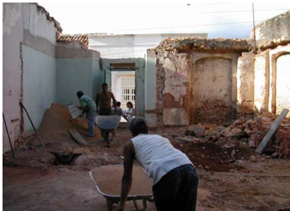
Trabajando en la rehabilitación de viviendas en el barrio de Tres Cruces, en Trinidad
